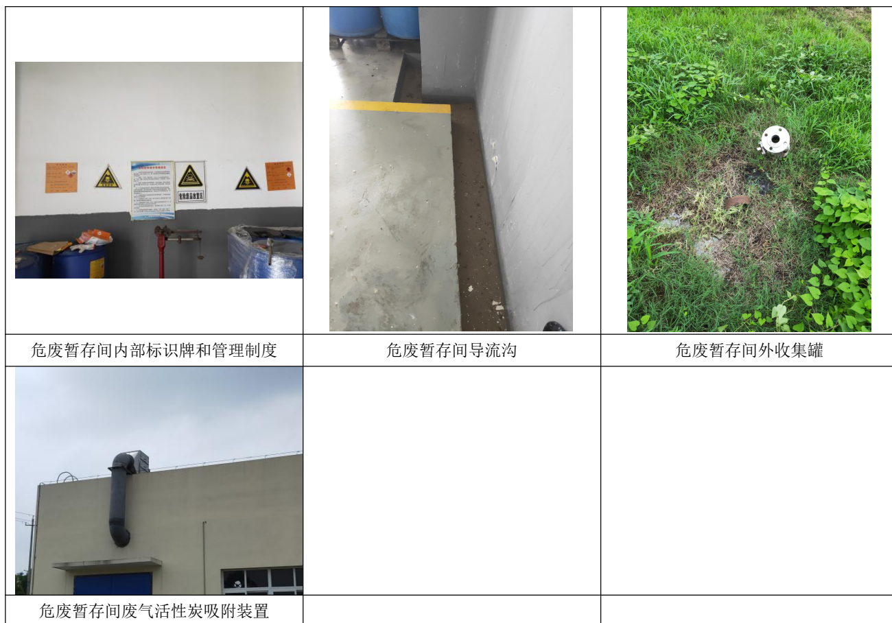
图 4.1-6 厂区危废暂存间建设图
