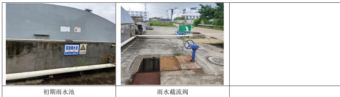
图 4.1-3 厂区初期雨水收集系统图
