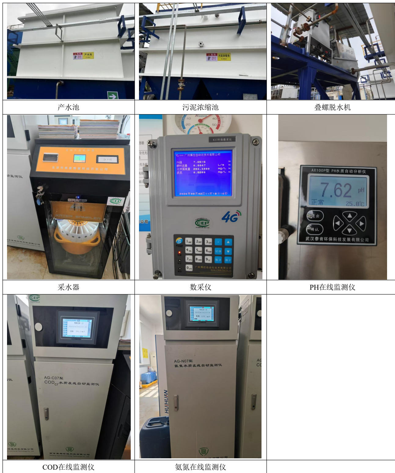
图 4.1-2 项目废水收集处理措施图
